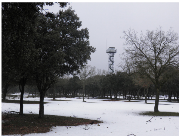
Foto 7. Torreta de vigilancia de incendios (Rodal 11, Monte el Viejo, Palencia, España).
